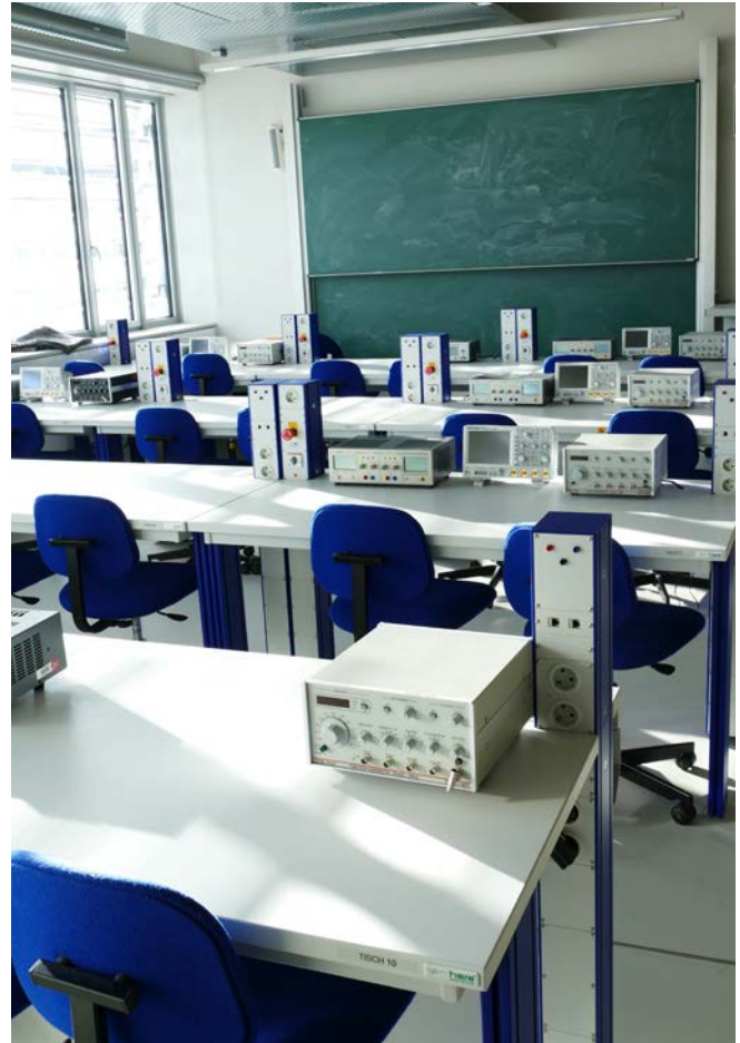
Abb. 20 sichere Anschlusspunkte in einem Übungsraum
