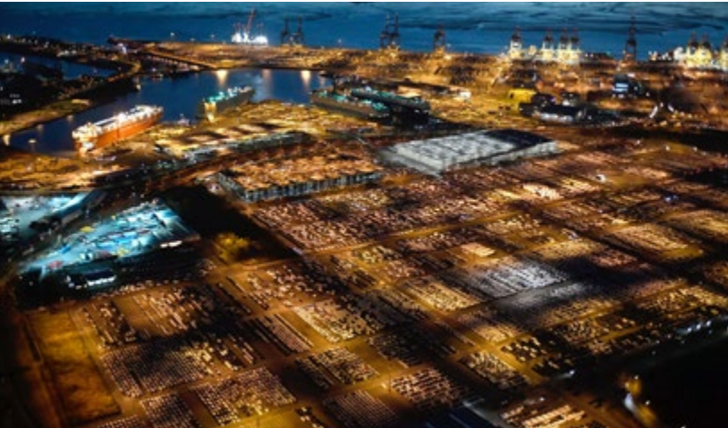
Das BLG AutoTerminal Bremerhaven gehört zu den größten Autodrehkreisläufen der Welt. In Zukunft sollen hier die Betriebsabläufe über Echtzeitstatusmeldungen und mobile Datenerfassung geplant und gesteuert werden.
